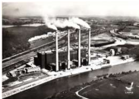
Figure 1 : Photographie d'une ancienne centrale thermique EDF étudiée
